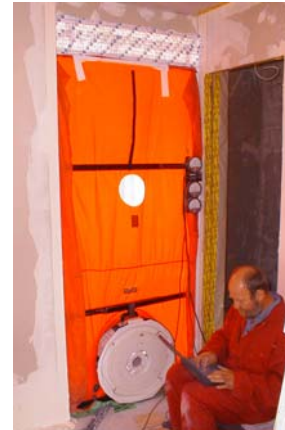
Abb. 1: Beim blower-door -Test wird mittels eines Gebläses, das in die mit einer Folie abgedichtete Haustür eingebaut wird, überprüft, welche Luftaustauschrate (ausgetauschte Luft des Wohnraums in Prozent pro Stunde) man bei einem Druckunterschied von +/- 50 Pa (zum äußeren Luftdruck) erhält. Der Wert muss unter 60% pro Stunde (techn. Bez.: n_{50} = 0,6 \text{ h}^{-1} ) liegen.
